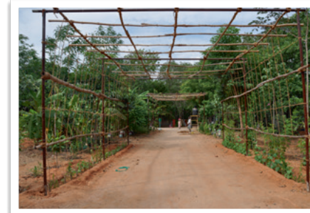
An diesem Gerüst sollen die «Hängenden Gärten» der AVS entstehen.
